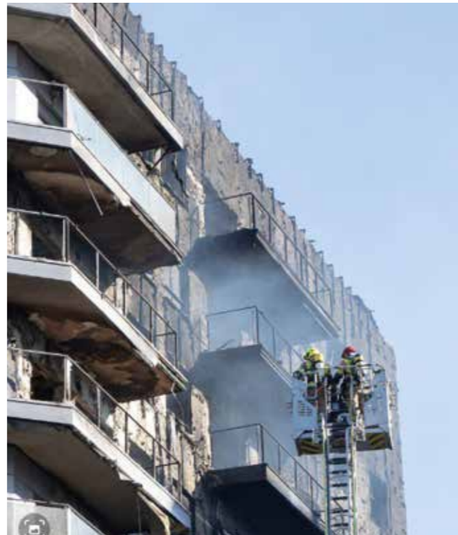
Imatge de l'edifici incendiat fa unes setmanes a València. Cedida per la Centre d'Emergències de la Generalitat Valenciana
