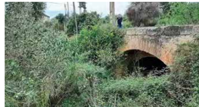
Estat actual del Pont dels Calderons
