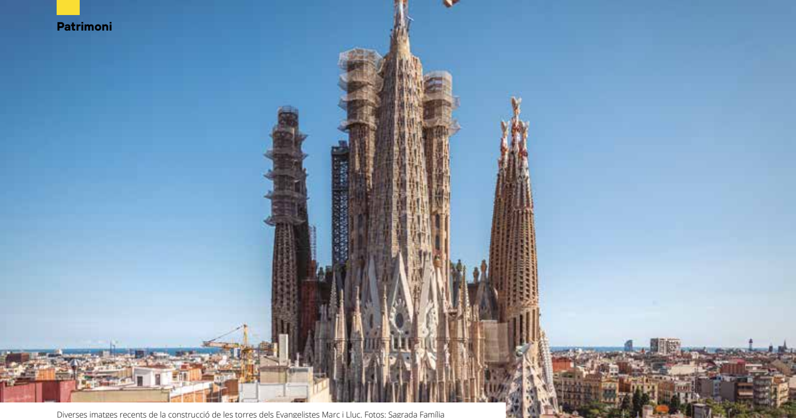
Diverses imatges recents de la construcció de les torres dels Evangelistes Marc i Lluç. Fotos: Sagrada Família
