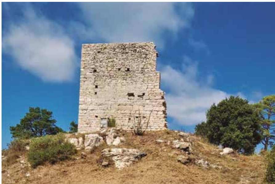
En aquesta pàgina, restes del castell de l'Albiol. A l'altra pàgina, fragment de la muralla de l'Albiol, que va consolidar Constecnia 3 i, detall del campanar de la Mussara, en la qual hi està treballant l'empresa de la Selva del Camp.
