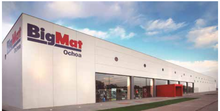
Instal·lacions de l'empresa Big Mat a la ciutat d'Oscà
