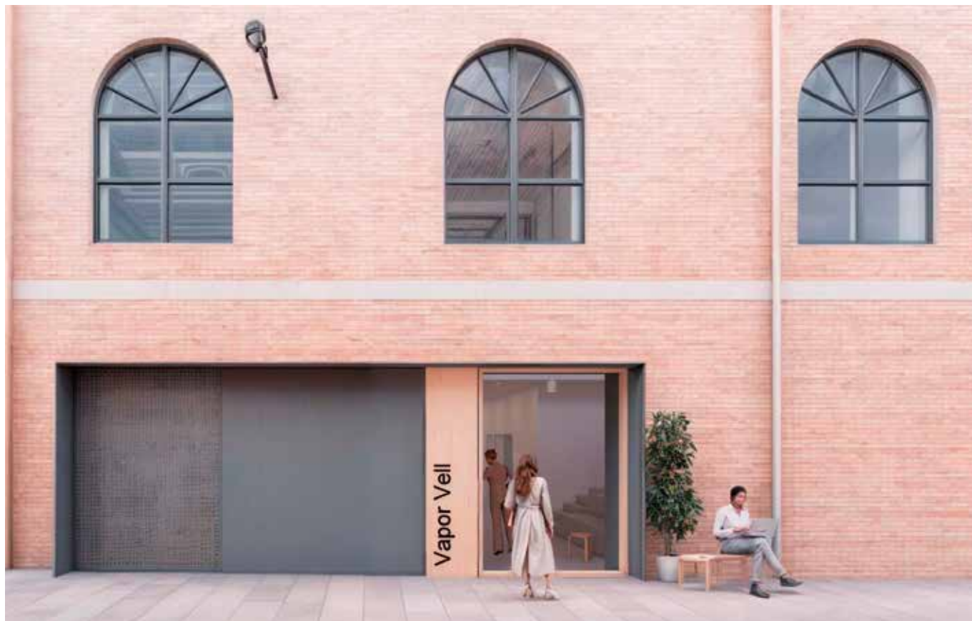
Imatges virtuals de la reforma del Vapor Vell, de la façana i del seu interior. A la dreta, visita d'obres de les autoritats i els responsables del projecte.
