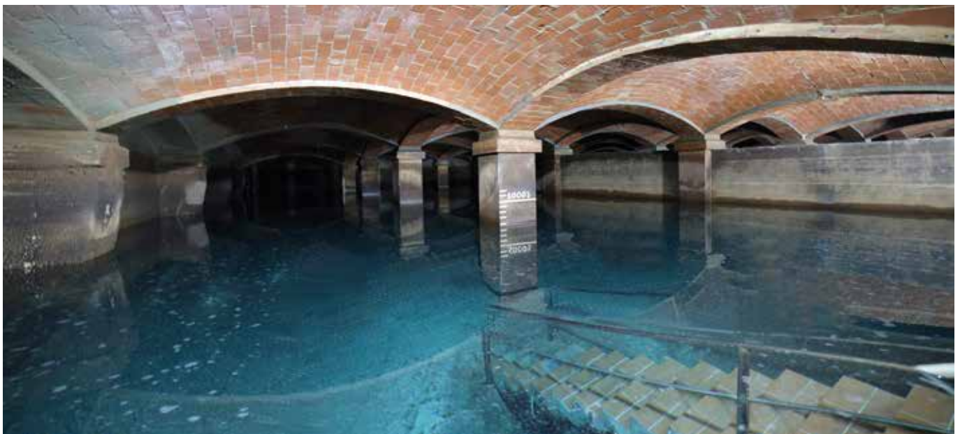
Imatge actual del Dipòsit Vell i a l'altra pàgina, dues imatges d'arxiu del moment de la seva construcció al primer terç del segle XX. Fotos: Ajuntament de Reus
