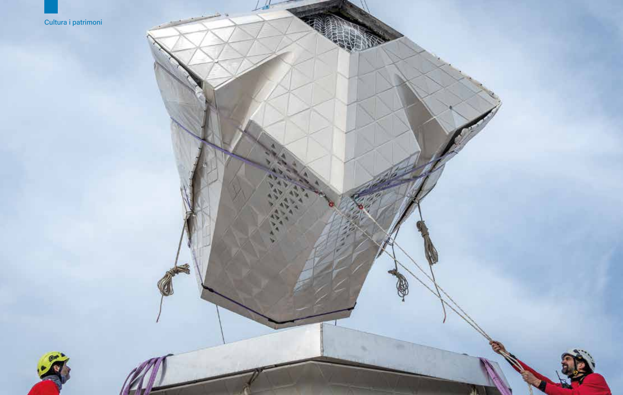
Diverses imatges de la instal·lació dels quatre braços de la torre de Jesucrist. Foto: @SagradaFamília
