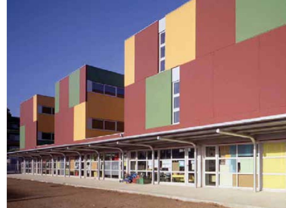
Construcció industrialitzada realitzada amb materials de Prefabricats Pujol.
